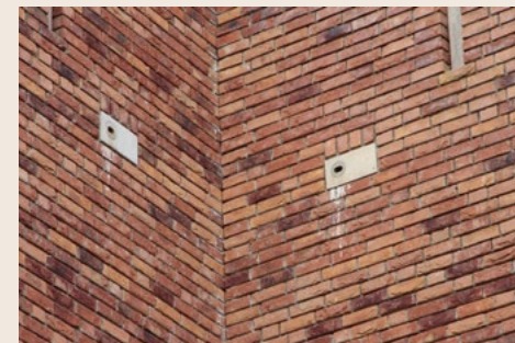
Haverleij - de nestkasten in de gevels van het kasteel, bewoond door spreeuw
