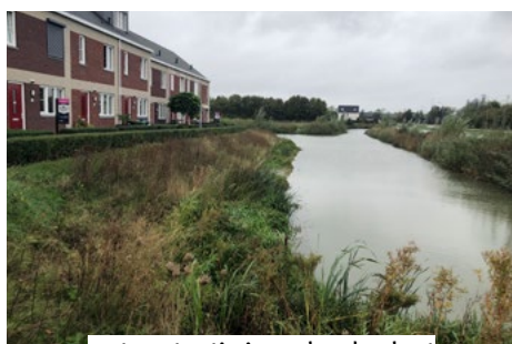
waterretentie in verbrede sloot
