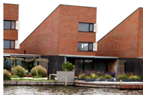
Zuiderburen - de oevers zijn hoog met damwanden waar kleine dieren niet tegenop kunnen
