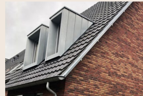
Groot Holthuizen - goede nestplaatsen onder de dakpannen (geen kantpan maar strip)
