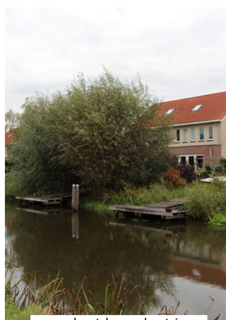
oever loopt door onder steiger
